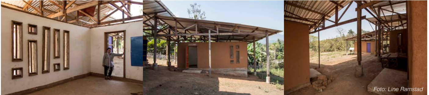
Fase II av totalt III for Gaw La Heh School. Når de siste to klasserommene blir ferdigstilt danner de tilsammen et lukket gårdsrom til opphold og lek.
