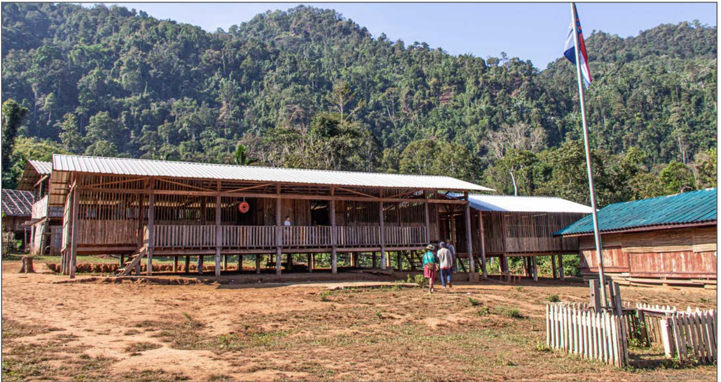
Klay Poe Klo barneskole. Det første byggetrinn ble fullført i 2018 og er selve hovedbygget. Andre byggetrinn fullført i 2019 er det frittstående klasserommet til høyre.
